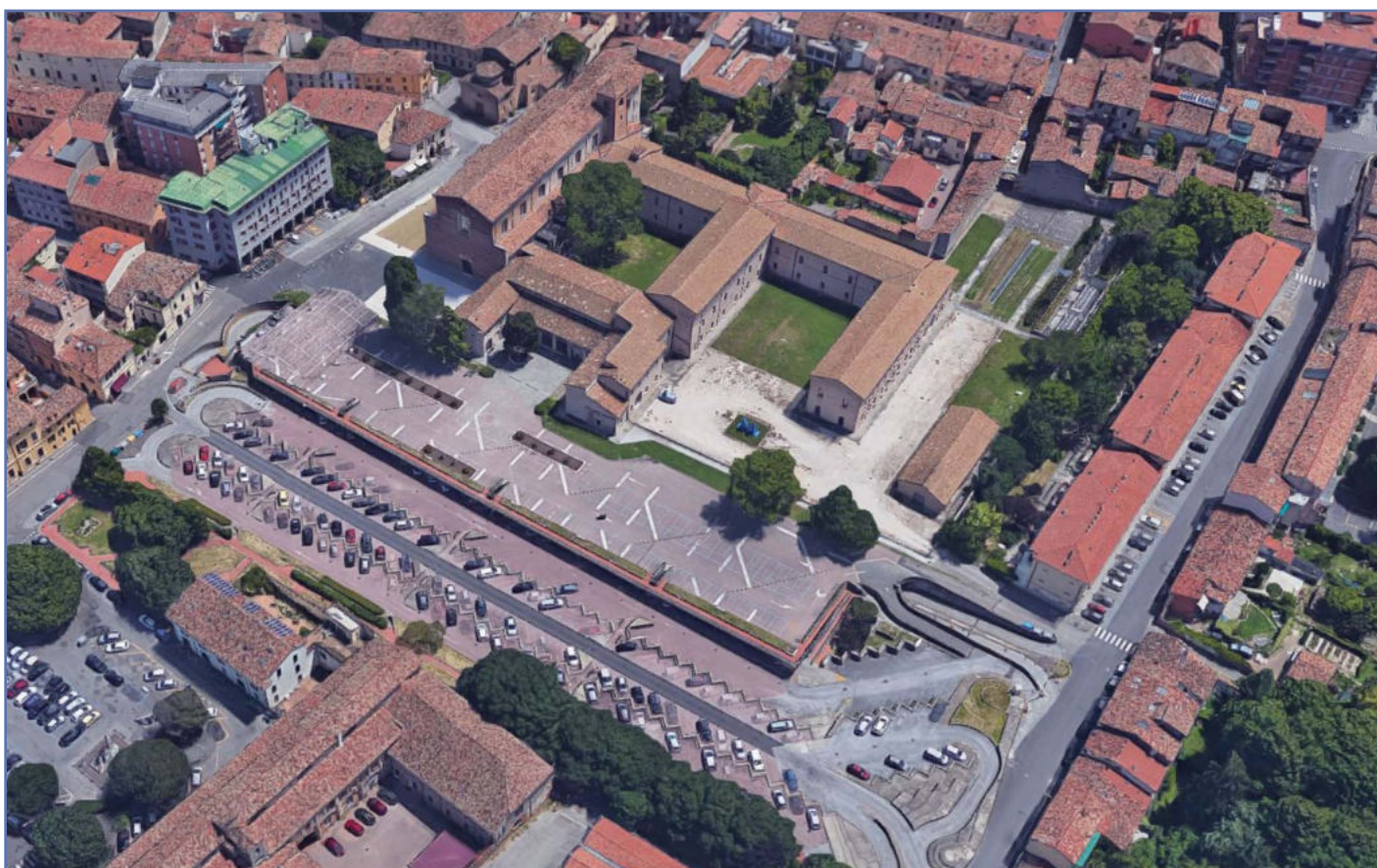
Figura 2. Forlì, parcheggio in Piazza G.da Montefeltro prima dell'avvio dei lavori (fonte: Google maps).
