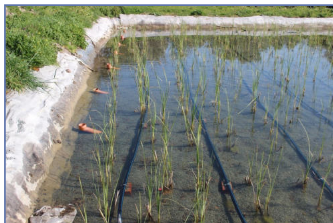
Figura 2. Una delle vasche di fitodepurazione (fonte: IRIDRA ).
