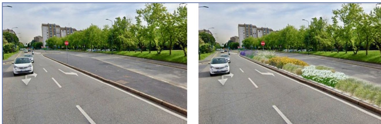
Figura 1. Comune di Milano: ante e post operam di un intervento di de-pavimentazione (fonte: Flickr ).
