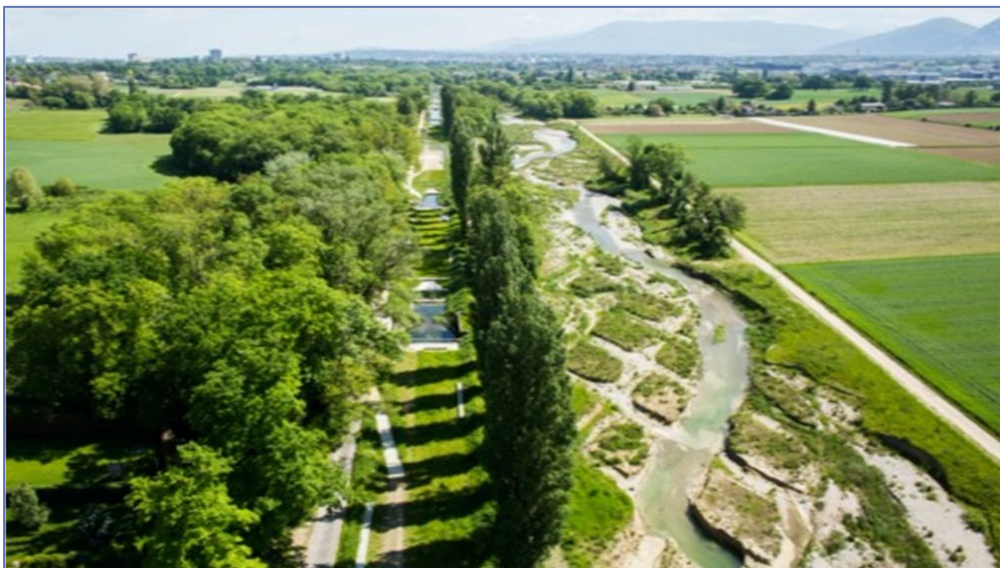
Figura 2. Il progetto di rinaturazione del fiume Aire (CH), finalizzato alla sicurezza idrogeologica, è basato sull'utilizzo della forza erosiva dell'acqua, al posto dell'escavatore. Nel tempo il fiume disegna le proprie traiettorie all'interno di uno spazio fisso, con risparmio di energia, CO 2 , tempo, denaro, trasporto dei materiali scavati, e con vantaggi vari tra cui il ripascimento dei litorali a carico del trasporto solido (fonte: Progetto "Atelier Descombes & Rampini", vincitore della IX Biennale internazionale del paesaggio del 2016, nella sezione "opinioni del pubblico").
