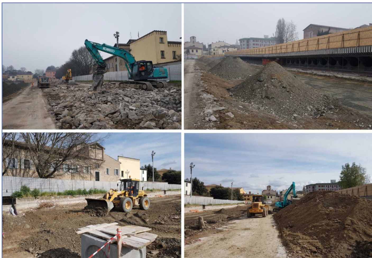
Figura 4. Forlì – Cantiere Giardino dei Musei, opere di demolizione e riporto del suolo 2021 (foto Comune di Forlì).
